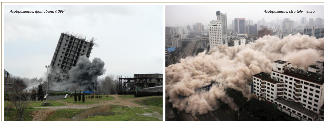
Рис. 3. Снос зданий (сооружений) взрывным способом
