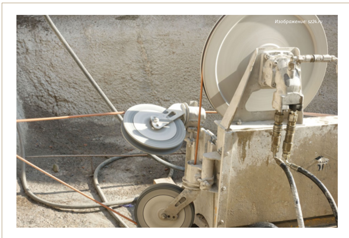
Рис. 2. Применение техники при механическом демонтаже зданий и конструкций
