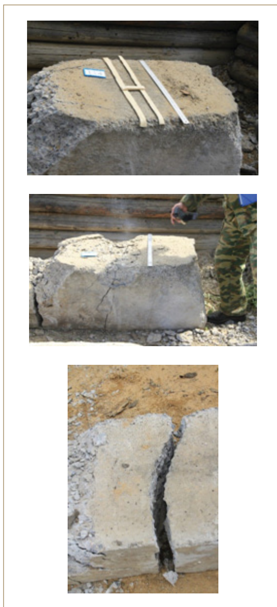
Рис. 7. Перебитие бетонного блока толщиной 520 мм с помощью БЛЗ
