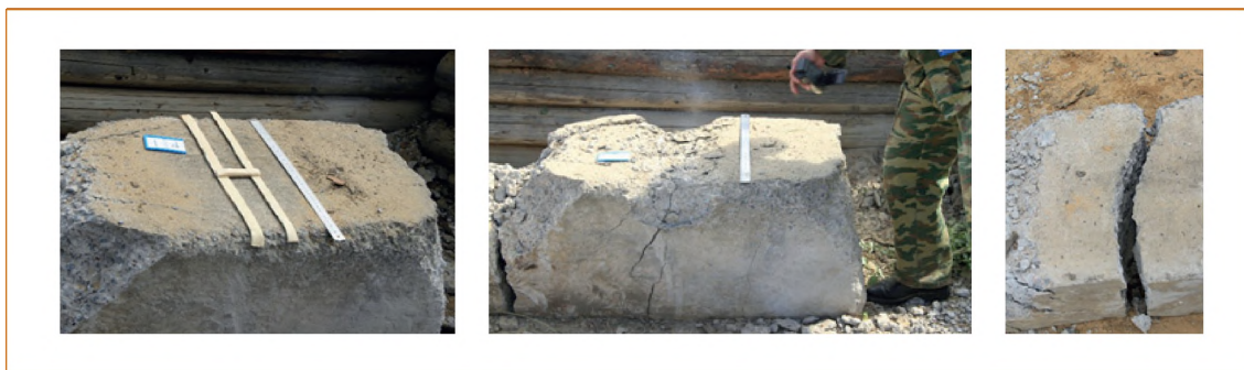
Рис. 4. Перебитие бетонного блока толщиной 520 мм с помощью ЗУВР
