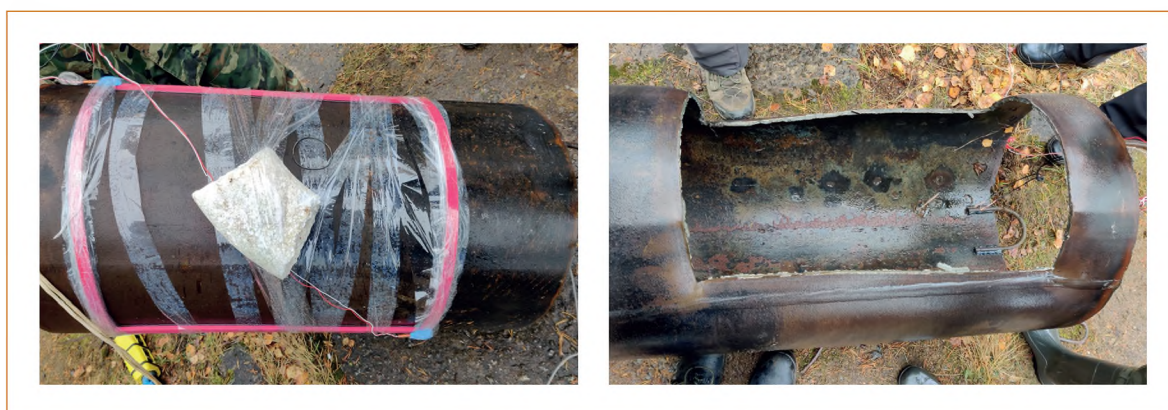
Рис. 9. Разрушение (резка) стальной трубы под водой
