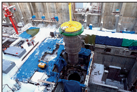
Корпус единственного в своем роде исследовательского реактора МБИР изготовлен на предприятии «Атоммаш» в Волгодонске и был доставлен на площадку в Димитровграде с опережением графика. Фото: предоставлено ГК «Росатом»
